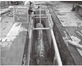
耐震管敷設状況
