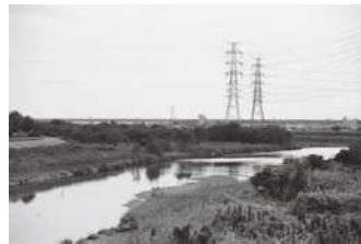
国道1号線町屋橋から下流の状況
