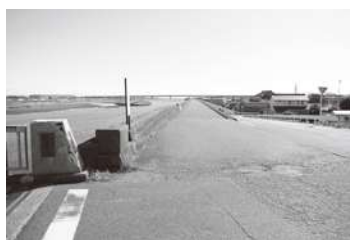
員弁川(町屋川)右岸堤防(日の出橋から下流)
